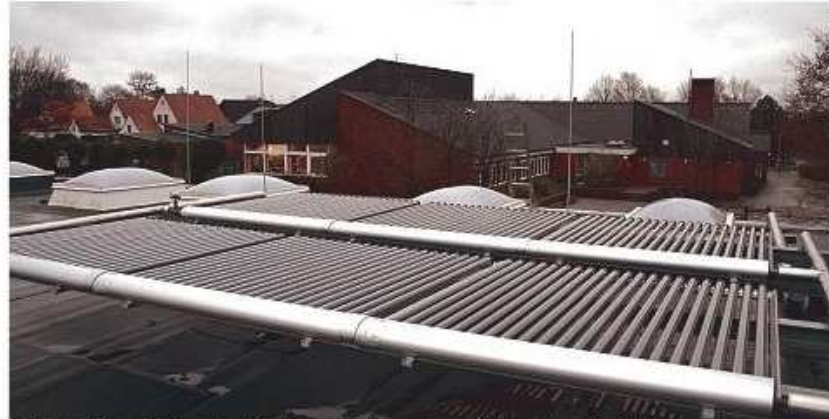
Auf dem Turnhallendach in Borgstedt wurde die Solaranlage installiert.
